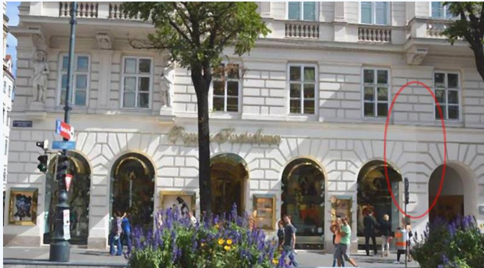
Fassade Wohn- bzw. Bürogebäude vor 2 Jahren saniert, und im EG teilbeschichtet (siehe Detailausschnitt).
