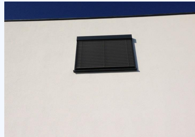
Fassade beschichtet Juni 2012, fotografiert Mai 2014 Verkehrsknotenpunkt Frequenz 20tsd. KFZ täglich
