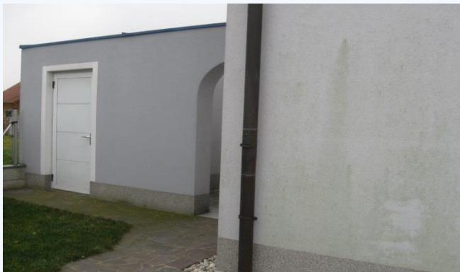
Fassade links neben Torbogen gereinigt und beschichtet. Fassade rechts gereinigt und mit Algizid behandelt. Durchführung Sept. 2011, fotografiert Mai 2014
