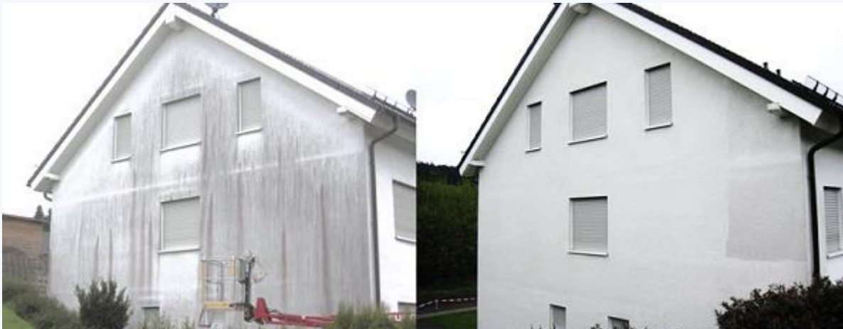
Untergrundvorbereitung (Reinigung) vor Aufbringen der Beschichtung.
