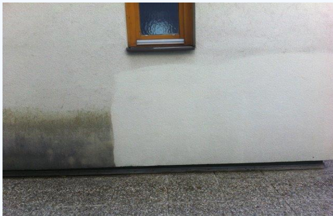
Anlegen einer Musterfläche
